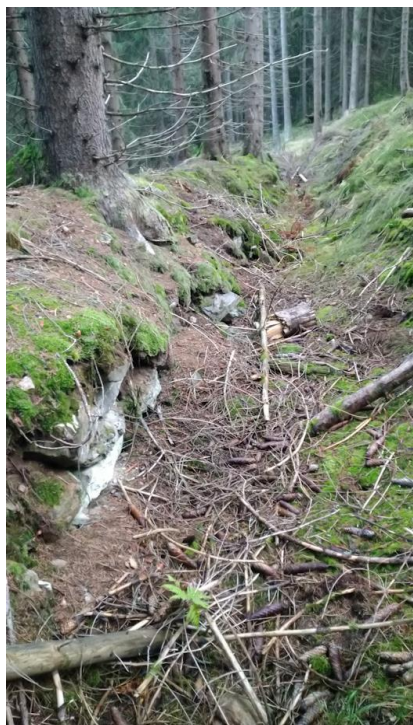
Příkop Blaufarbenwerkgraben, který přiváděl pohonnou vodu ke kobaltovému mlýnu od Blatenského potoka, a vodní příkop od Tichého potoka (foto: Michal Urban)
