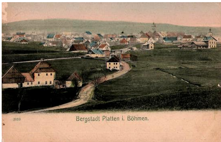
Horní mlýn (vlevo dole) na pohlednici vydané po roce 1900, tzv. Porkertův rybník na druhé straně silnice do Nových Hamrů (při konci Blatenského vodního příkopu) tehdy ještě neexistoval
