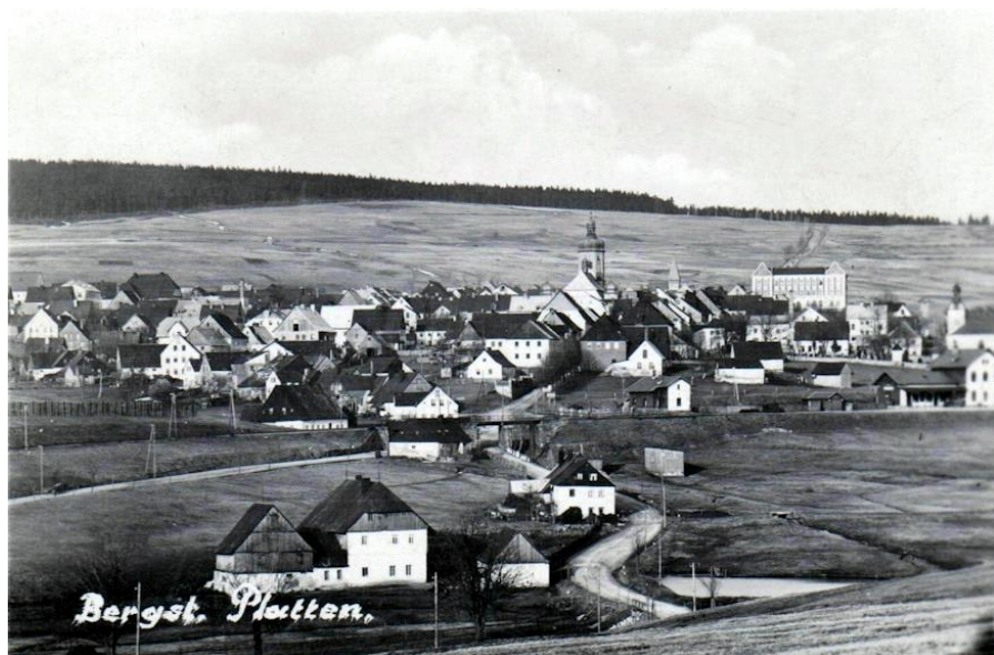
Horní mlýn (v popředí) před rokem 1930 na fotografii Ruperta Fuchse. Objekt sestával ze tří částí, hlavní budovy byly v přízemí vyžděné z kamene, v patře hrázděné
