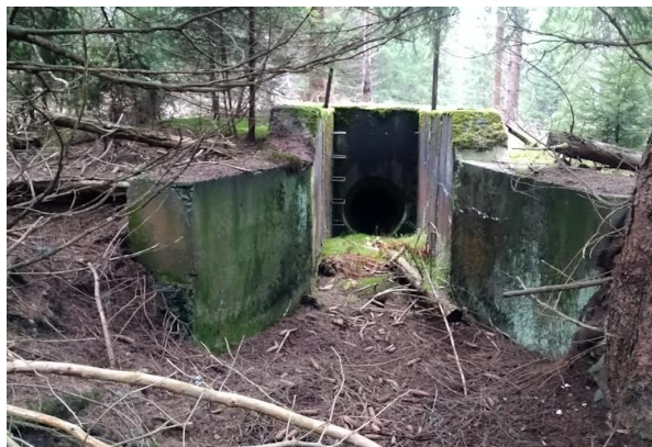
Potrubi pro přívod vody na turbínu pily (foto: Michal Urban)
