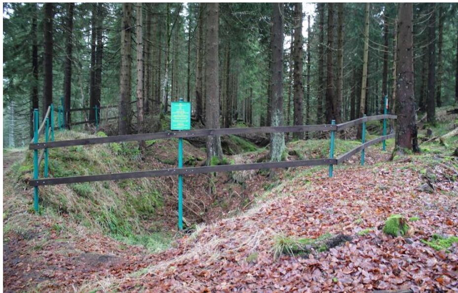
Celý pás dobývek na žíle Nanebevzetí Panny Marie je z bezpečnostních důvodů obehán plotem (foto: Bedřich Lühne)
