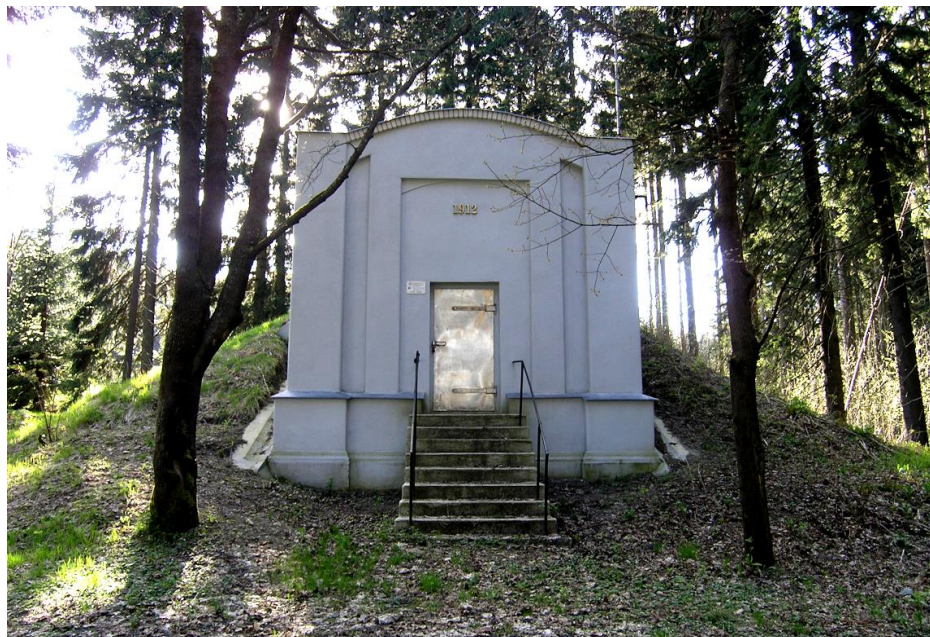
Hlavní vodojem je stále dobře zachovaný, vodu však již dnes Pernink čerpá odjinud (foto: Michal Urban)
