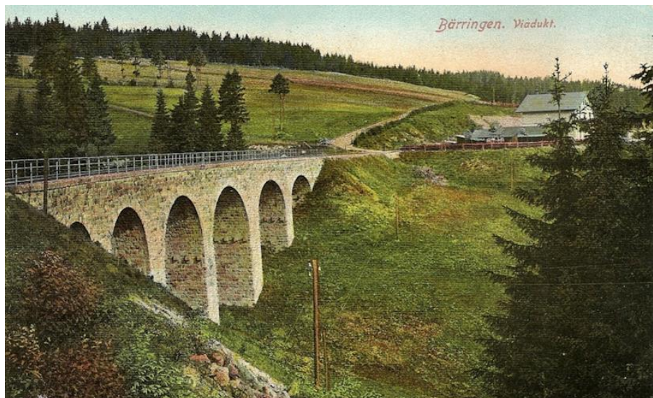
Viadukt kolem roku 1910
