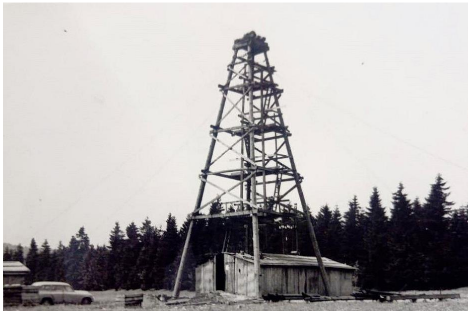
V okolí Perninku probíhal i vrtný průzkum uranových rud, na snímku vrtná věž č. 62 s neznámou lokalizací, vrtem byla zastižena přechodná zóna mezi svorovou a fylitovou sérií.
