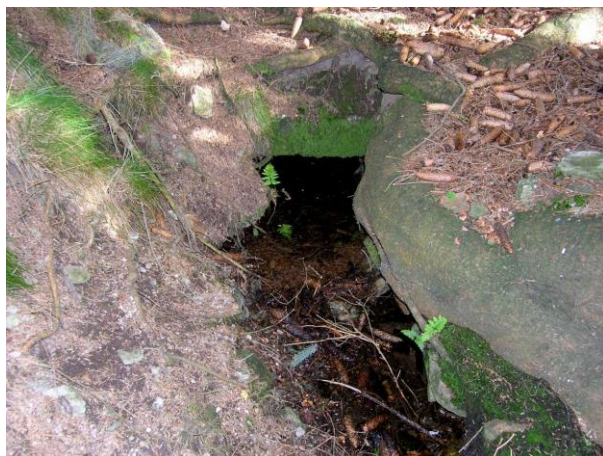
Ústí štoly jihozápadně od štoly Železná koruna v roce 2008. V současnosti je už jen sotva viditelné, voda z něj však stále vytéká (foto: Michal Urban)
