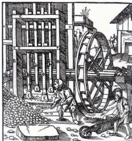
Stoupa na drčení rudy (Agricola, 1556) Pochwerk (Agricola, 1556)
