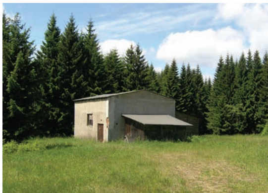
Bývalá strojovna dolu Východní Abertamy Ehemaliges Maschinenhaus der Grube Východní Abertamy
