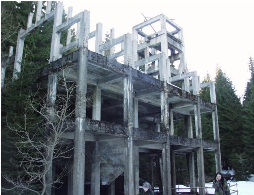
*Betonskelet des Hauptschachtes (Foto P. Rojík)*
