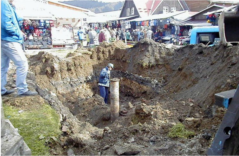
Sanierung und Nachverfüllung des Schachtes Magdalena im Oktober 1999 (Foto: Archiv DIAMO VEB)
