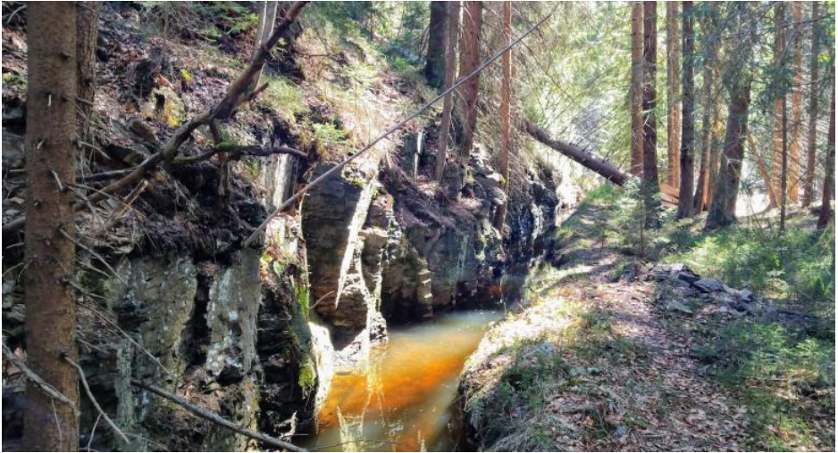
Die überwiegende Strecke des Grabens wurde durch den Felsen gehauen (Foto: Michal Urban))
