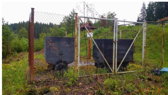
Die Mündung (Hängebank) des Schachtes Slovanka ist eingezäunt und mit einem Betondeckel abgeriegelt. (Foto: Michal Urban)
